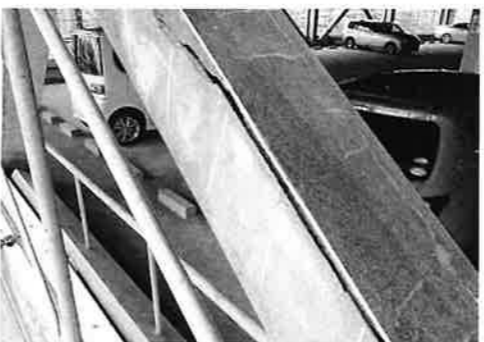
3階南側ブレース
