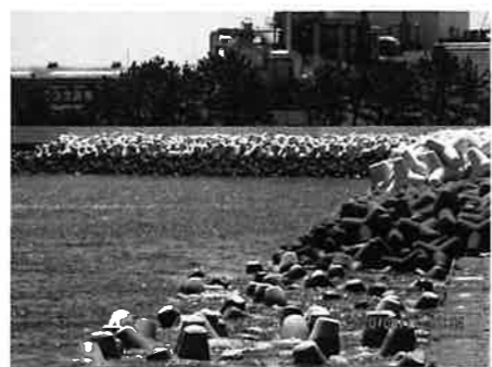
高潮対策として積み増された幸浦のテトラポッド
