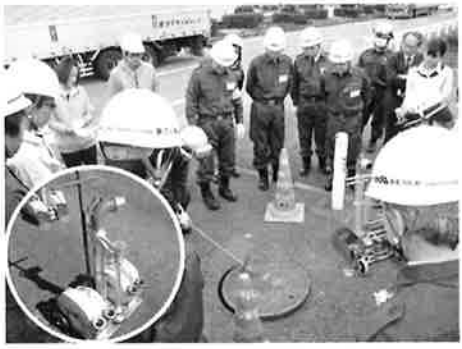
マンホールの開け方を習得(円内は「火消し君」)
