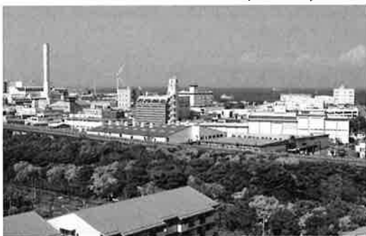
南西側から見た横浜マーチャンダイジングセンター
