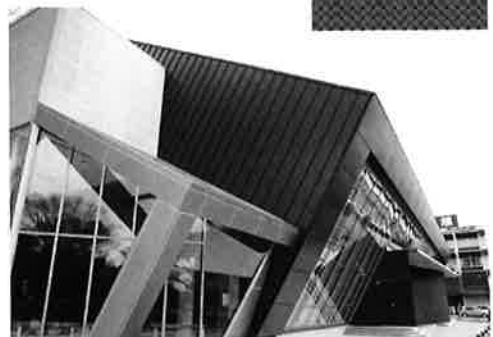
「ビッグキューブ」外観。特徴的なキューブデザインにより、ランドマーク機能を果たす。屋上には太陽光発電ユニット(ソーラーパネル)を設置
