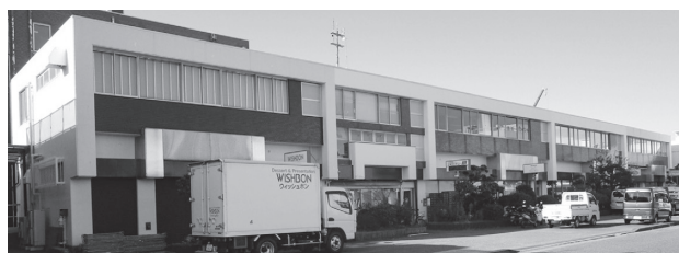
外壁塗装等の施工が完了した五社連棟建物
